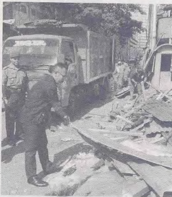
Lurah Suparyogi mengangkut puing bangunan yang dibongkar di Jalan Benhil, Jakarta Pusat.
