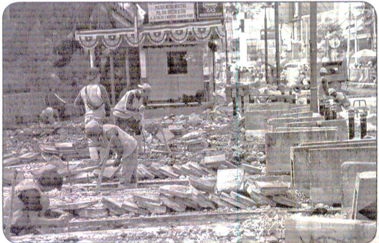
Beri Kenyaman Pejalan Kaki, Revitalisasi Jalur Pedestrian di Jalan Blora :Aktivitas pekerja saat menyelesaikan revitalisasi pembangunan jalur pejalan kaki atau pedestrian di Jalan Blora, Jakarta Pusat, Minggu (3/9/2023). PT Mass Rapid Transit (MRT) Jakarta akan merubah Jalan Blora dan Jalan Kendal menjadi jalur pejalan kaki yang akan digunakan menjadi perluasan plaza transit Stasiun KCI Sudirman dan Stasiun MRT Dukuh Atas BNI yang membentang sepanjang 150 meter.
