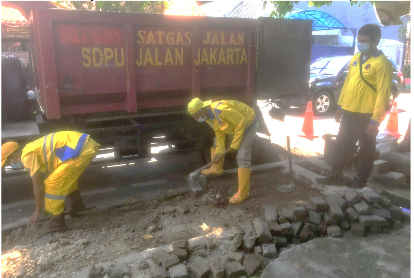
Satgas Bina Marga Kecamatan Kemayoran melakukan perbaikan trotoar. Foto: pusat.jakarta.go.id
